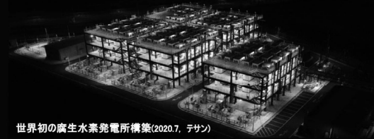
世界初の腐生水素発電所構築(2020.7, テサン)
