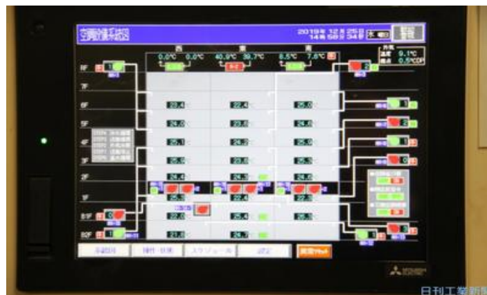
(사진) 온도나 CO2의 농도를 센서로 감지, 에어컨디셔닝을 효과적으로 가동 (야마다 전기 이케부쿠로점의 온도감시상황)
